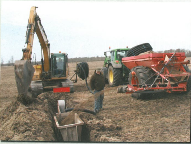
Her er det Øland Entreprenørforretning der er i sving lægning af rør med drænkasse og filtergrus. Indehaver Jens Oluf Thomsen var lige forbi for at se hvordan arbejdet skred frem.
